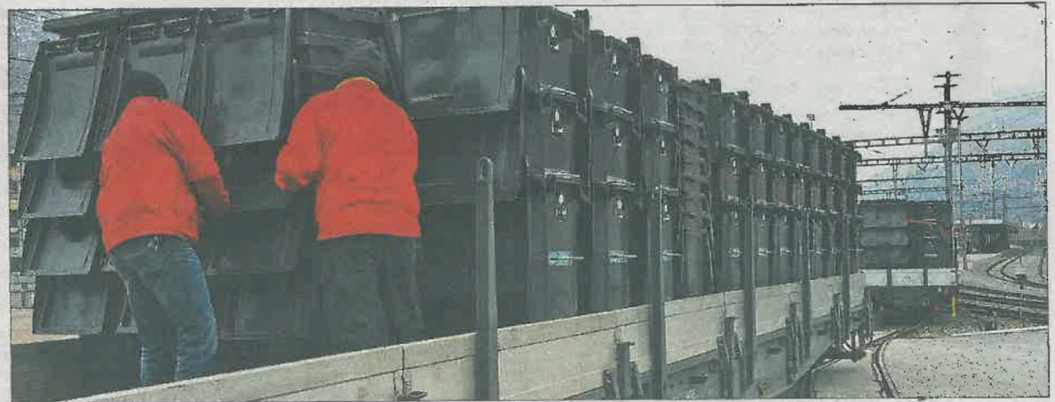
Die neuen Container werden für den Transport nach Zermatt auf Bahnwagen verladen.
